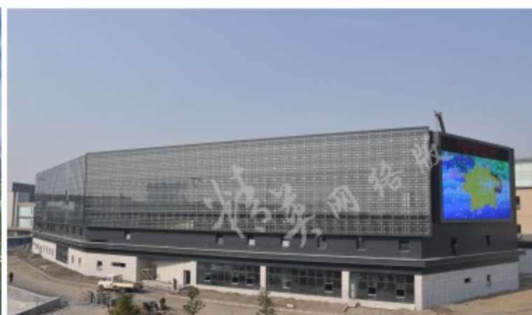
中南国际商城光伏幕墙
