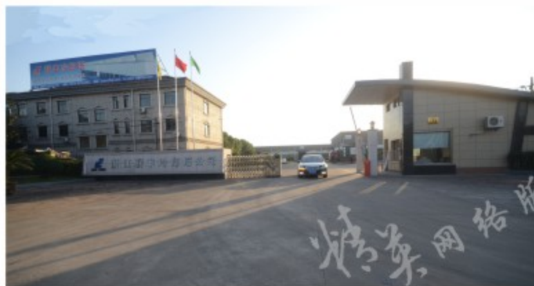
浙江联丰冷却塔公司
